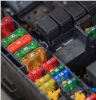
Überprüfung von Kfz-Sicherungen
